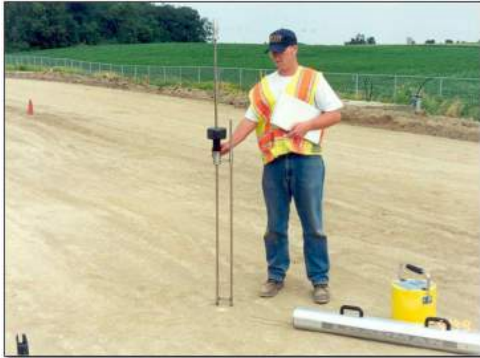
Gambar 2.2 Perletakan alat DCP pada tanah yang akan diperiksa
